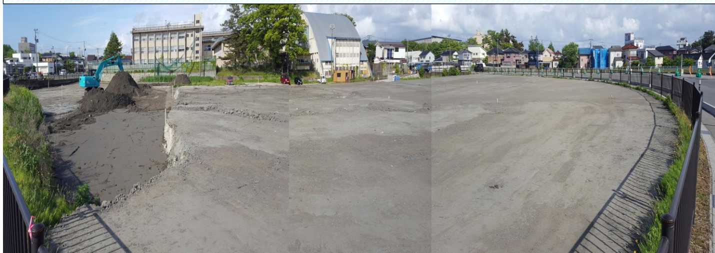
改良土の再利用状況（旧酒田商業高校グラウンド造成盛土）
