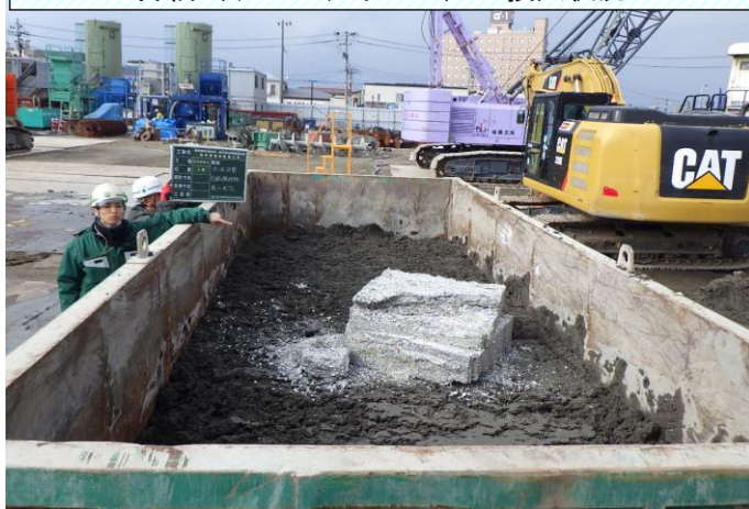
改良土の再利用状況（旧酒田商業高校グラウンド造成盛土）
