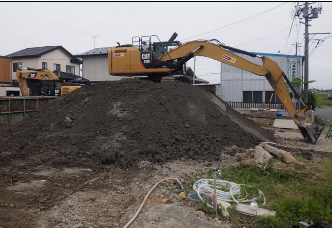
改良土の集積・仮締固め・養生（イメージ）
