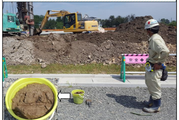
セメント系固化材の投入・攪拌状況
