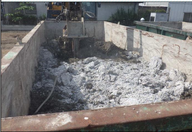
改良土の集積・仮締固め・養生（イメージ）
