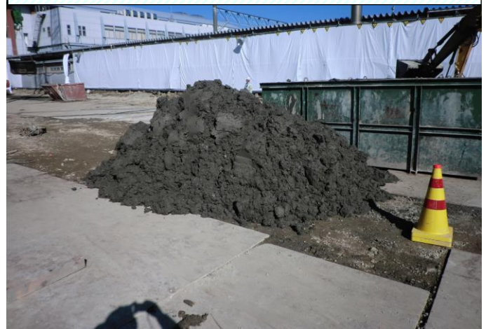
改良土の埋戻し状況（人力敷均し）
