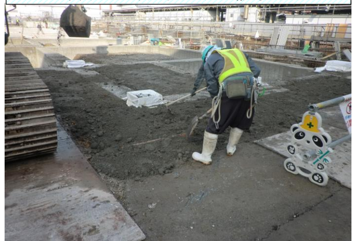
改良土の埋戻し状況（人力敷均し）
