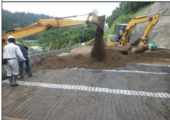
改良土の締固め状況
